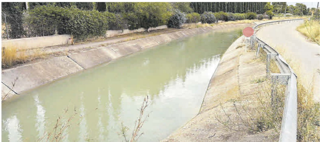
Canal principal del postrasvase Tajo-Segura, de la margen derecha, en el tramo de Alhama-Lorca.
